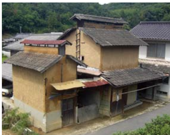
● 小田郡矢掛町／昭和20年代末の建設／4坪建てと2坪建ての併設（西日本たばこ耕作組合提供）
